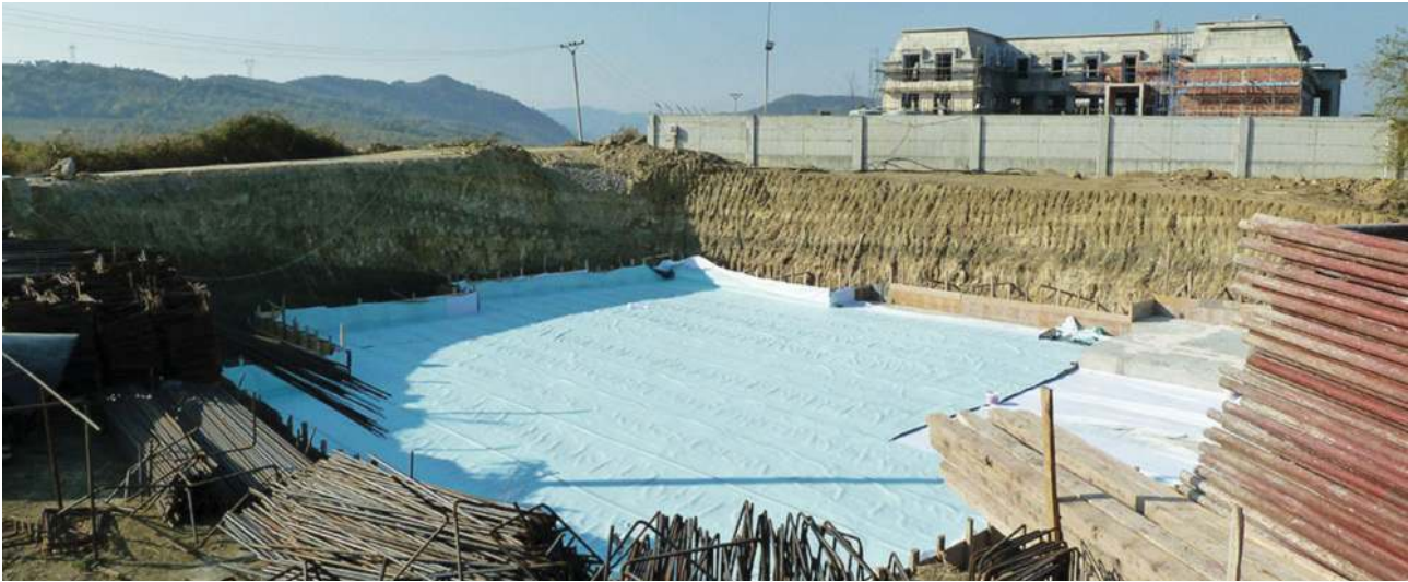
ХИДРОИЗОЛАЦИОНА МЕМБРАНА ЗА ОБЈЕКТИ ПОД ВЛИЈАНИЕ НА ПОДЗЕМНИ ВОДИ НАЧИН НА ВГРАДУВАЊЕ: СО ТОПЛО ЗАВАРУВАЊЕ
